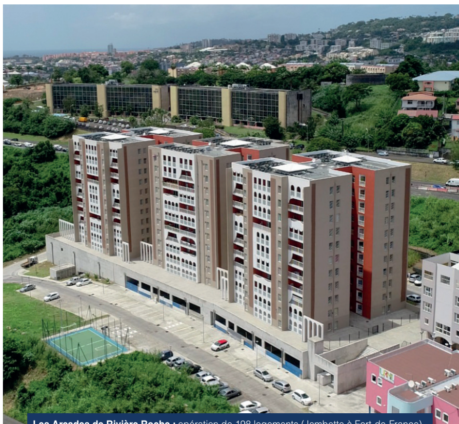
Les Arcades de Rivière Roche : opération de 198 logements (Jambette à Fort-de-France)
